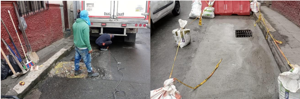
Ilustración 10 - Parcheos en pavimentos rígido
