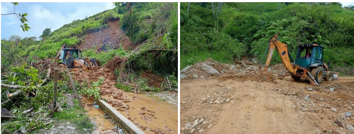
Ilustración 4 - Remoción de derrumbes vía corregimientos El Cedro y El Pueblito
